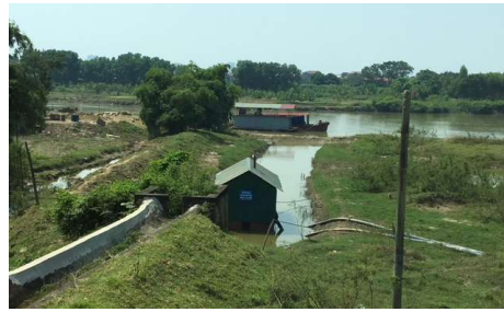
Trạm bơm cấp 1
