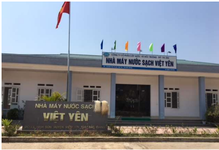
Nhà máy nước sạch Việt Yên
